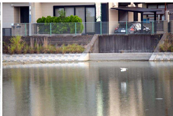
越流堰（水位低下時 2016.8.14）
